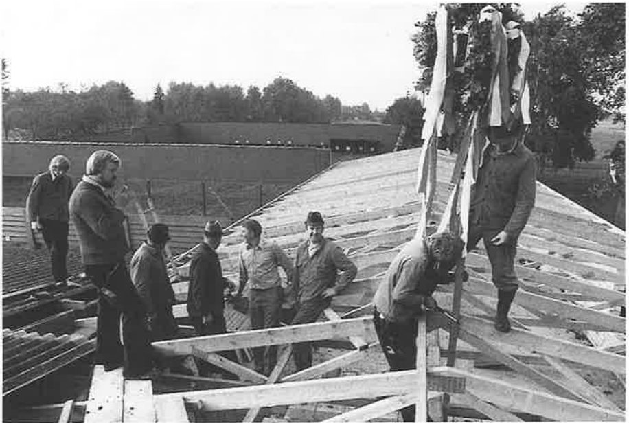
Über dem Schießhallenbau weht der Richtkranz.
