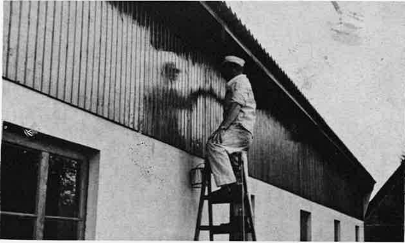
Der letzte Anstrich bei der neuen Schießhalle. Helmut Gefken beim Arbeitsdienst 1958.
